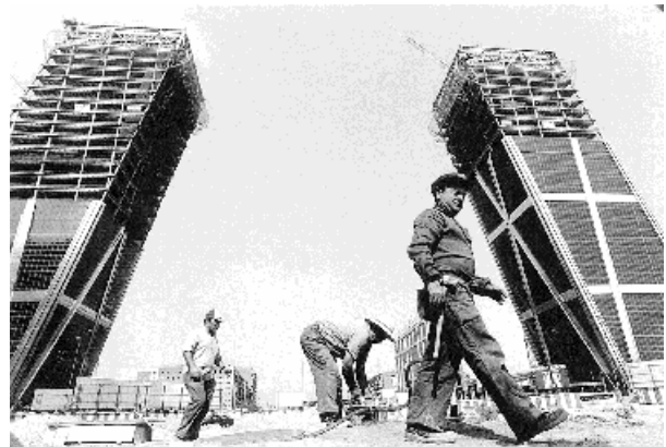
Las 'torres de Kio' en construcción
